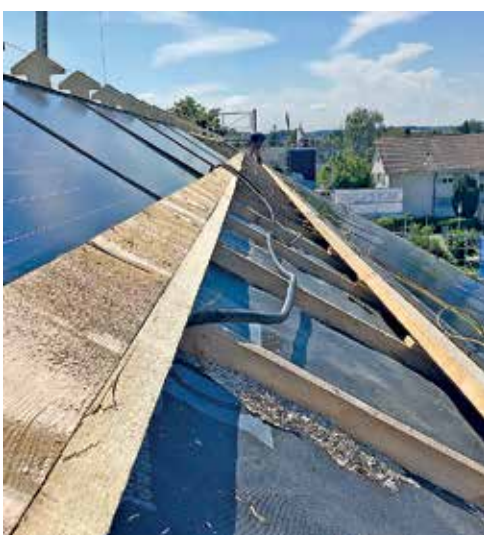
Dachsanierung im Sommer 2016
